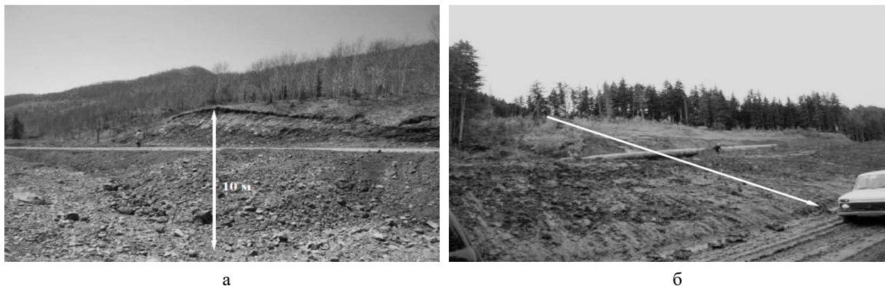
Рис. 1. Укладка трубопровода в местах развития ОГП [4]:
